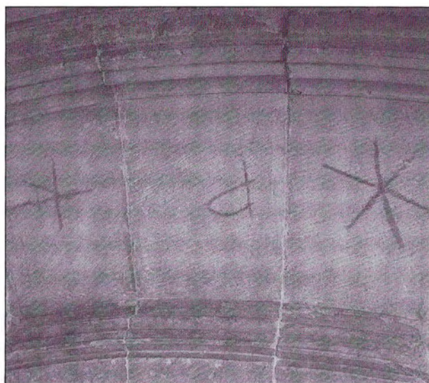
FIGURA 15: SÍMBOLS PINTATS EN NEGRE SOBRE ALGUNES DE LES DOVELLES DE L'ARC D'ACCÉS (FOTO RAMON SOLÉ)
